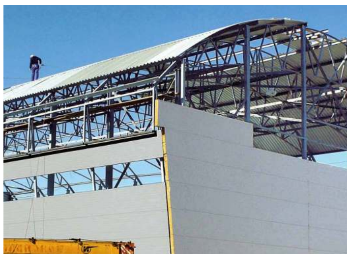
Монтаж спортивного комплекса с кровлей из продольно-гнутого профиля (Казахстан, г. Астана)
